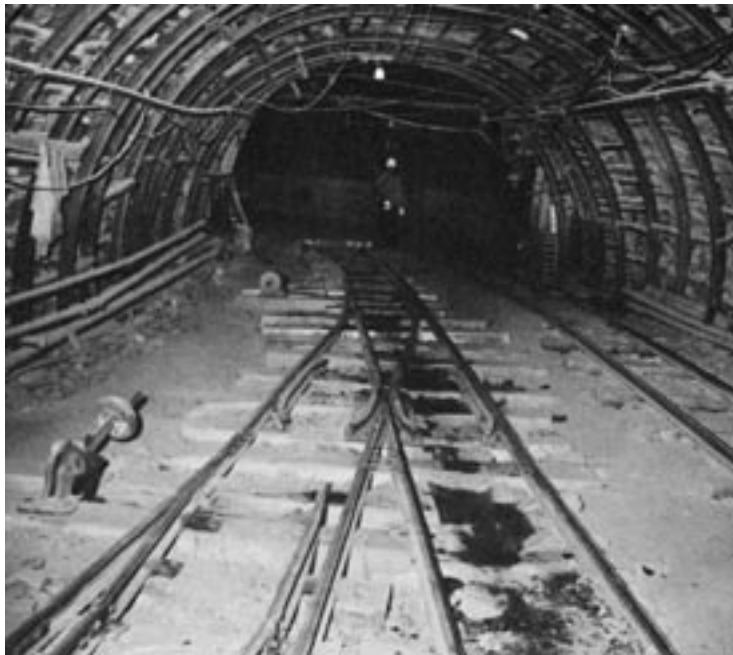
中央斜坑巻立坑
