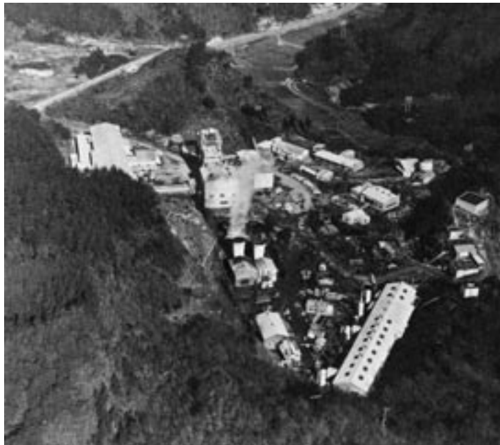
西部礫業所立坑全景
